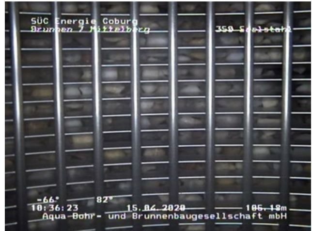
Abb. 8 – Kamerabefahrung Wickeldrahtfilter
