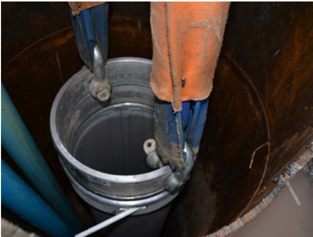
Abb. 7 – V2A-Ausbau DN 300 (Vollrohr bis 42 m und Wickeldrahtfilter bis 108 m, SW = 3 mm)
