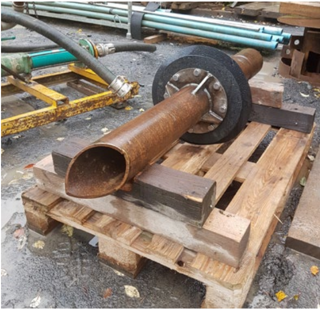
Abb. 6 – Provisorisches System zur hydraulischen Trennung von Bohrlochabschnitten
