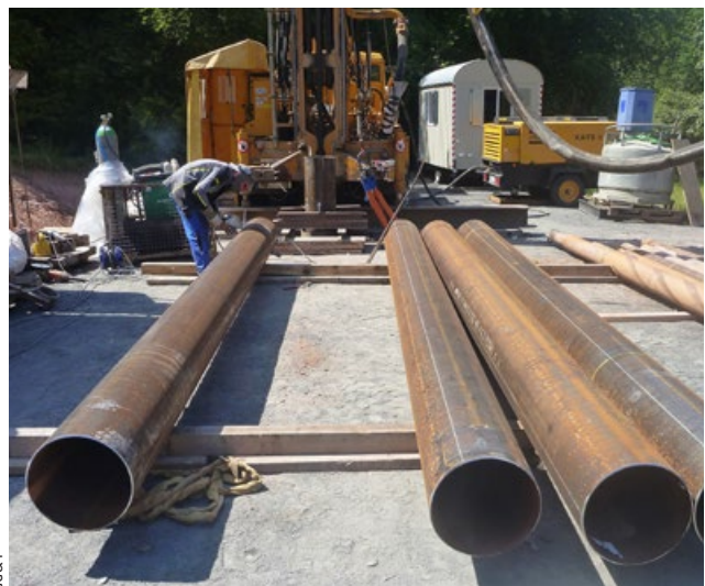
Abb. 3 – Hilfsverrohrung (406 mm)
