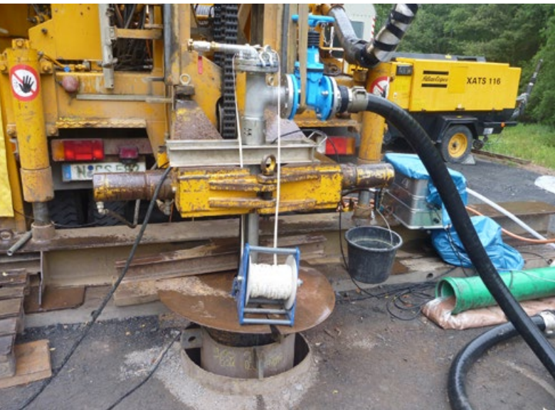
Abb. 4 – Pumpversuch 1 wurde mit einer eingebauten Unterwassermotorpumpe durchgeführt
