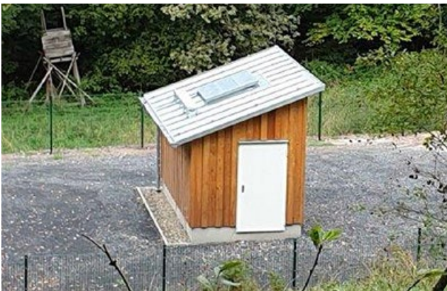
Abb. 9 – Abschlussbau aus einem formgegossenen Betonfundament und einem Aufbau in Holzständerbauweise
